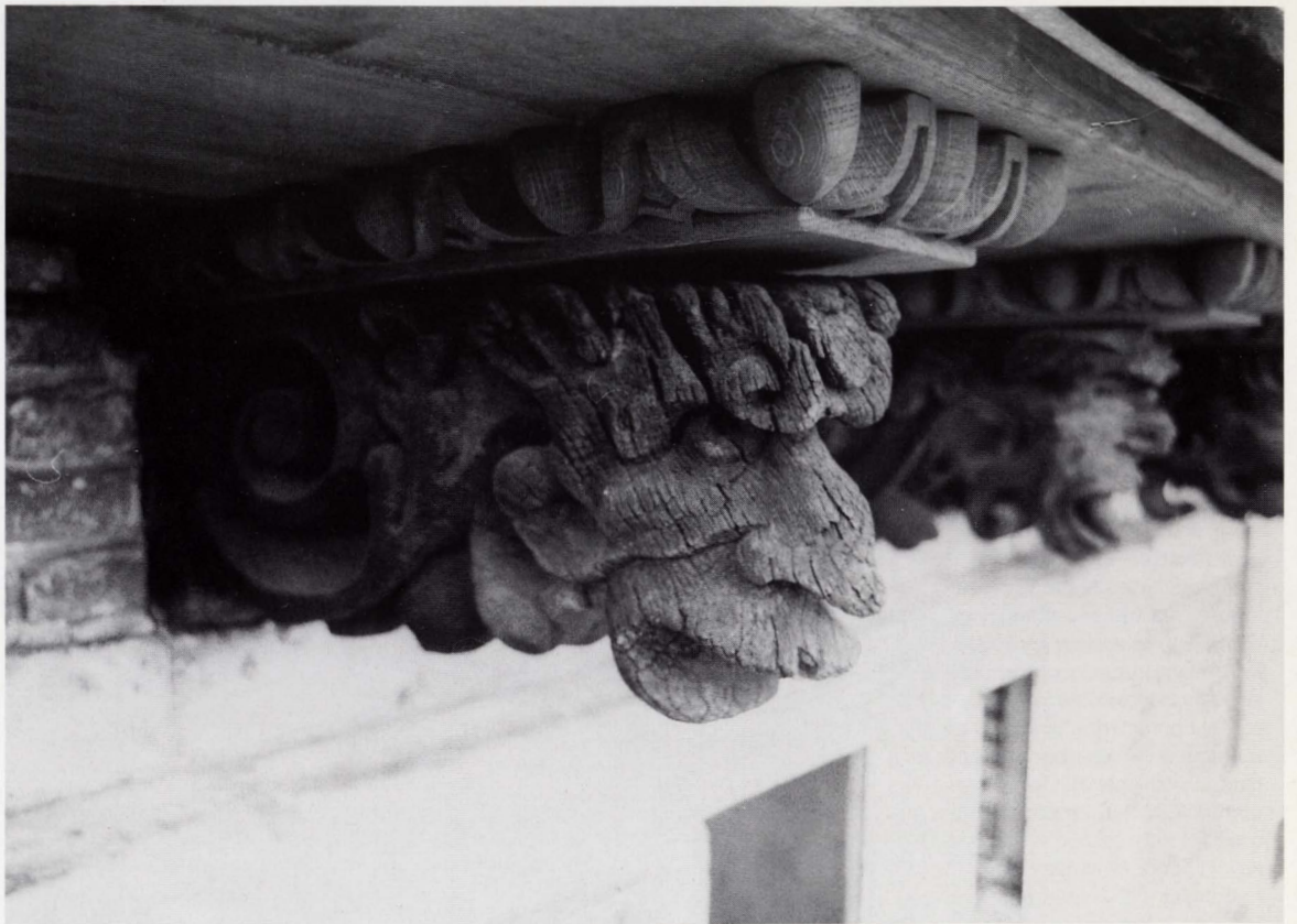
Caermersklooster, infirmerie Gerestaureerde console Trommelstraat, Gent
