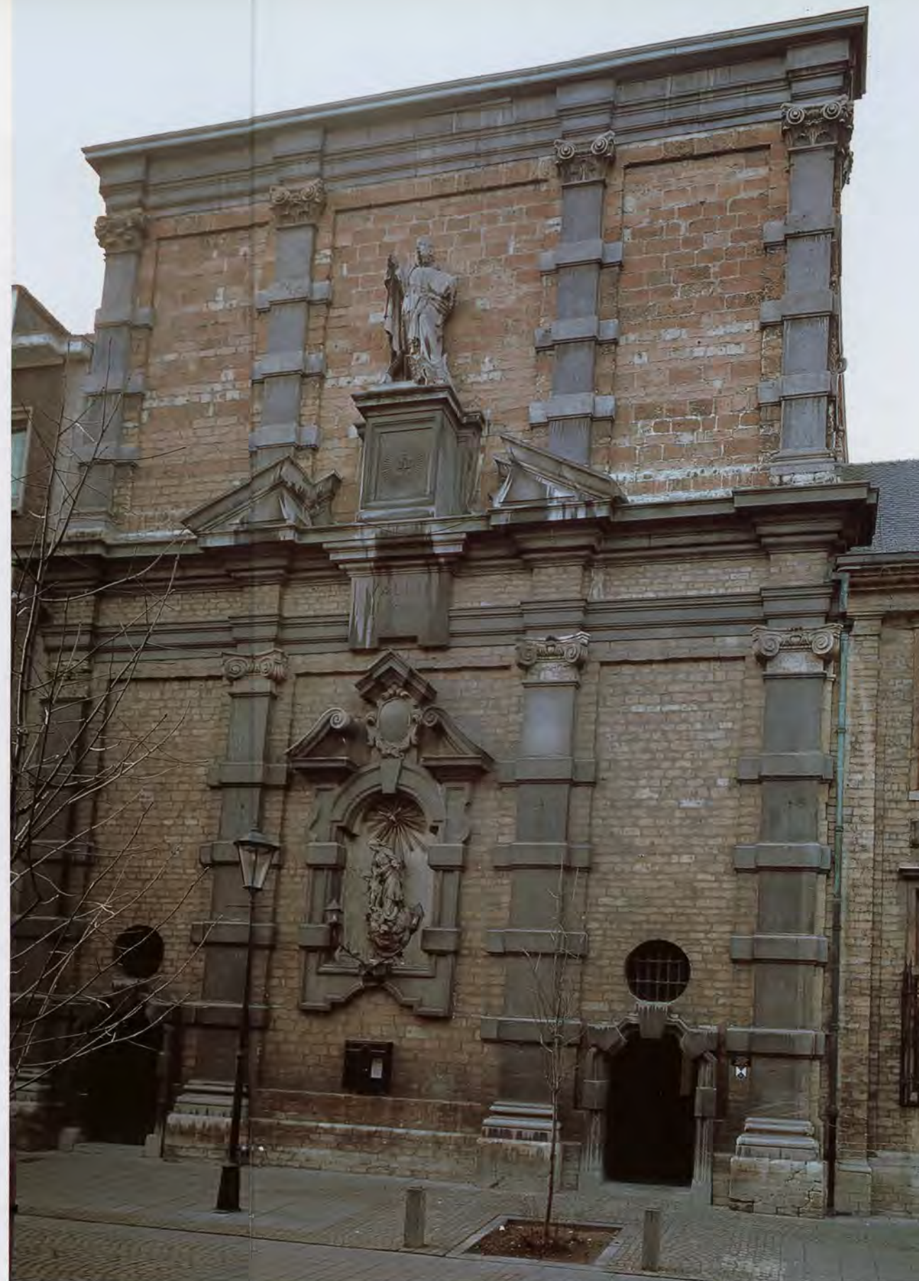
Voorgevel van de voormalige kloosterkerk van Leliëndael
